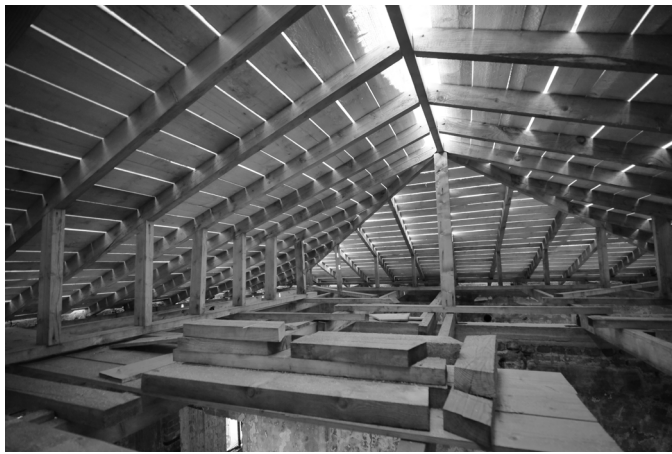
Der neue Dachstuhl
