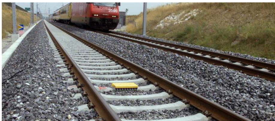
In der Bildmitte eine Eurobalise, ortsfeste Transponder, die mit dem Zug kommunizieren und u. a. Signale ersetzen.
